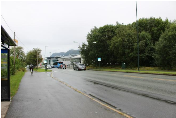
Figur 2-3. Bilde av eksisterende fortau og busstopp langs Borgundvegen, nord for planområdet. Foto: Norconsult.
