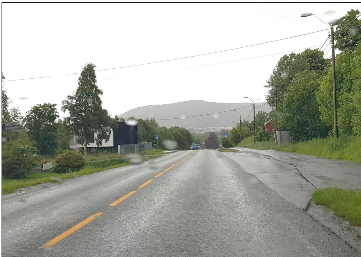
Figur 3-5: «Myrabakken» holdeplass, nordgående retning. Bildet viser typisk utforming av holdeplasser langs den parallelle lokalveien i prosjektavgrensningen «Spjelkavikveien».
