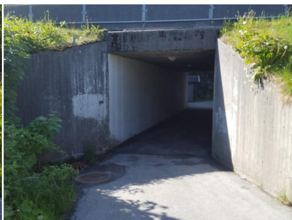
Figur 6-24 Kulvert under arm E39.
