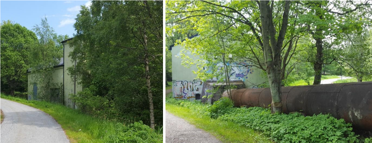
Figur 8-26 Kraftstasjon med rørgate. Foto Multiconsult.
