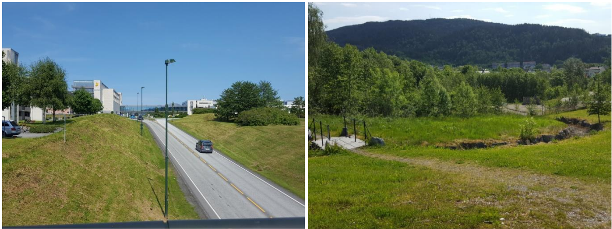
Figur 6-35 Dagens fv. 5948 stiger på opp mot Moa Figur 6-36 Et av flere aktivitetsområder i fra lavereliggende rundkjøring i sør. Veganlegget i delområdet. Sti til venstre leder til kanlrundtur. seg selv er en fysisk barriere, men den omkringliggende grønnstrukturen reduserer visuell barriere.
