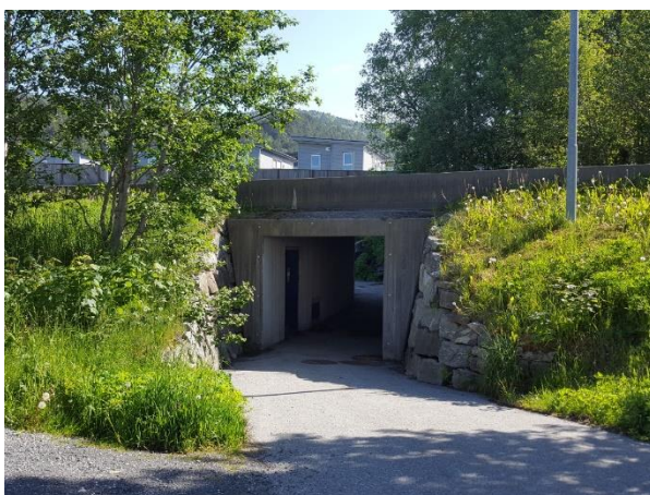
Figur 6-23 Kulvert Urdalsundergangen. Vanskelig å se rundt svingen.
