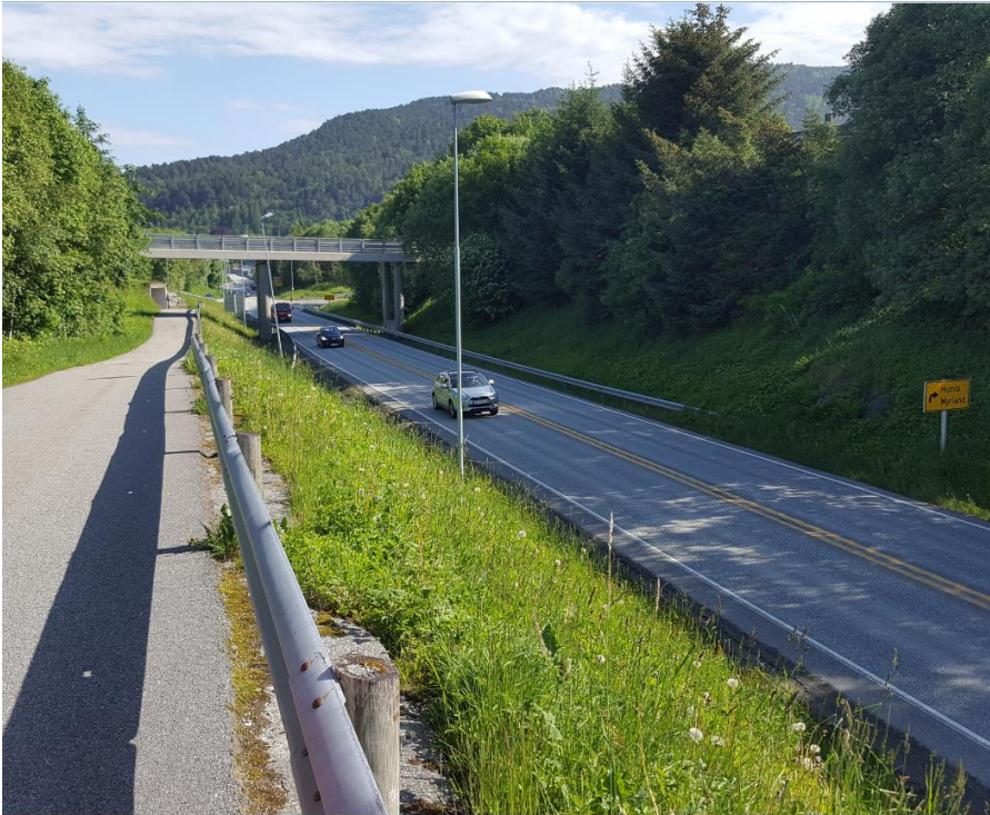
Figur 6-14 Tørlevegen, GS-veg langs E39 og kulvert under E39 lengst bak i bildet.
