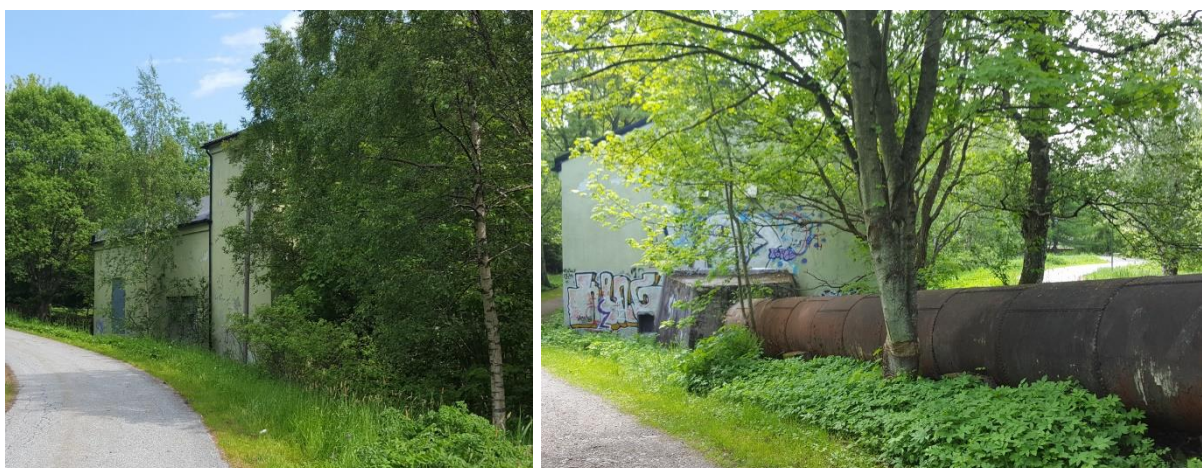
Figur 0-20: Spjelkavik kraftstasjon med rørgate.
