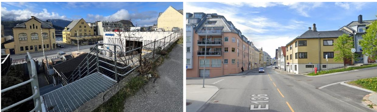
Figur 23. Til venstre: gangforbindelse mellom Øvre og Nedre Strandgate. Til høyre: Veikryss mellom Nedre Strandgate og Aspegata.
