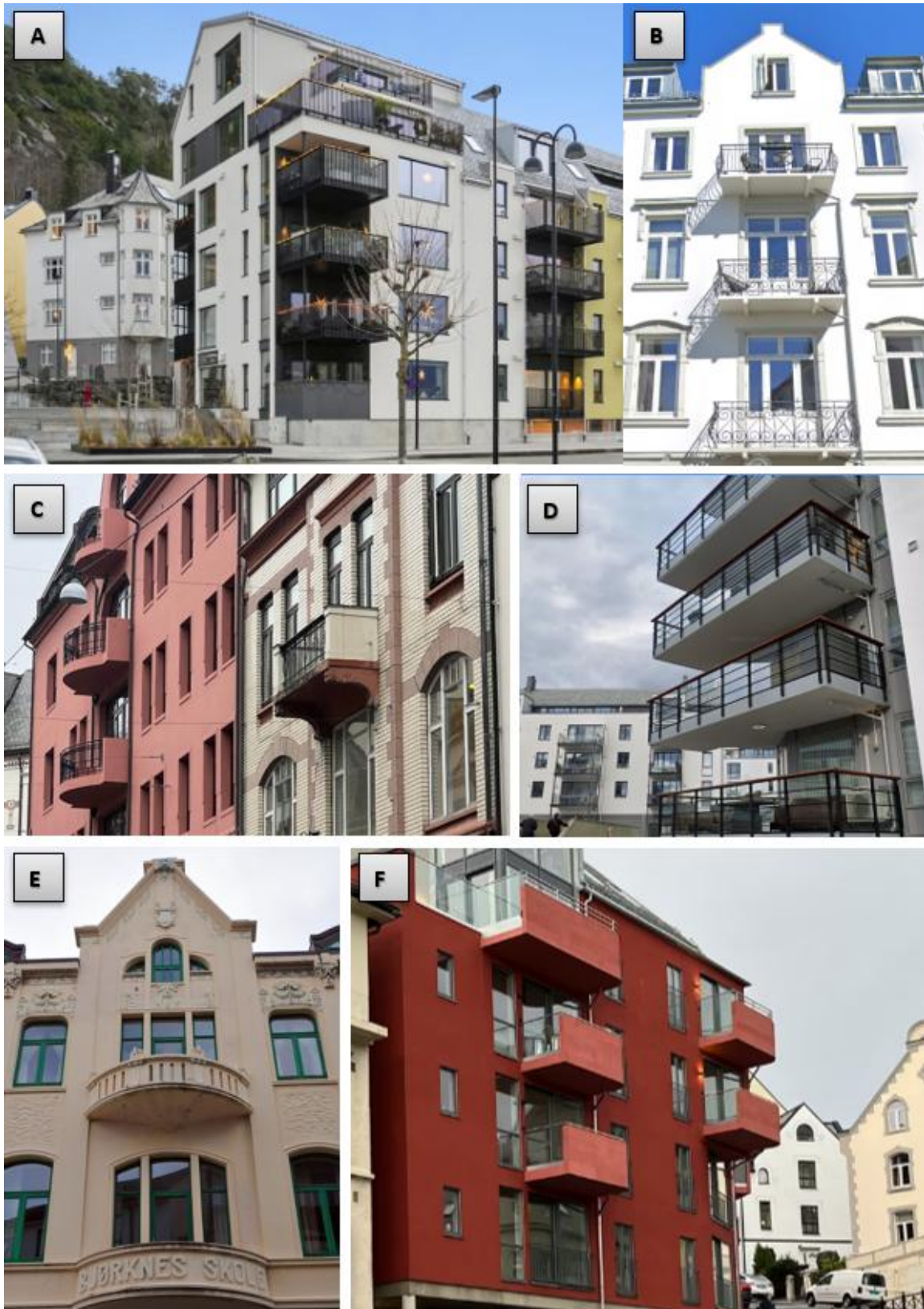
Figur 566: Rekkverk på sentrumsbebyggelsen innenfor sentrumsplanen: A - Nybygg m/vertikalt spilerekkverk; B - Jugendbygg med senere påbygg m/smijernsrekkverk med ulik detaljering; C - Gjenreist jugendbygg (til venstre) og opprinnelig jugendbygg (til høyre) m/mur og smijern; D - Nybygg m/horisontale spiler og innvendig glass; E – Jugendbygg m/mur (både tett og m/åpninger); F - Nybygg m/betong og glass.
