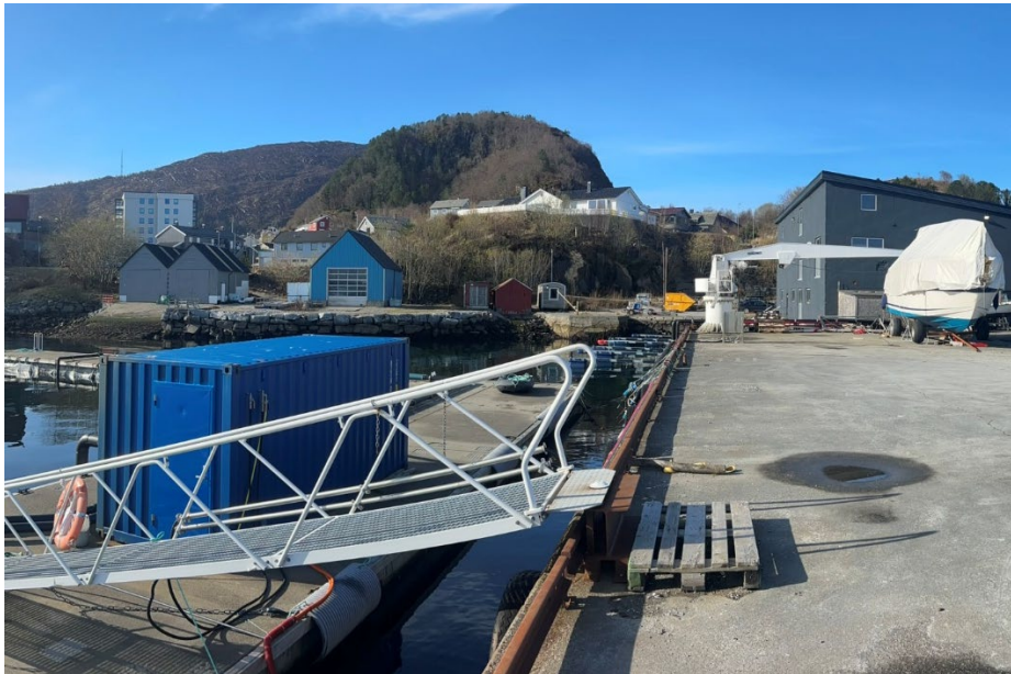
Figur: Kaiområde med Naust i bakkant. Boligene i bakkant ligger 10-15 m høyere enn industriområdet.
