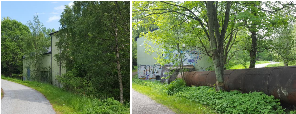
Figur 0-15: Spjelkavik kraftstasjon med rørgate.
