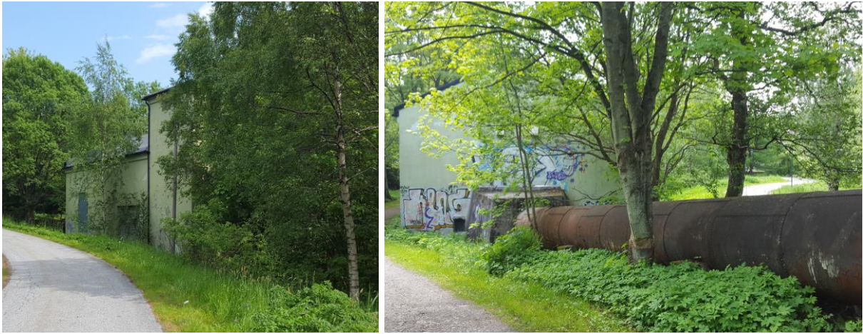
Figur 4-14: Spjelkavik kraftstasjon med rørgate.
