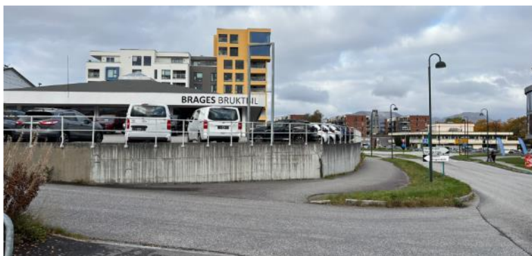
Figur 4-14. Østre del av planområdet med Midtmoa i bakgrunnen. Her er høydeforskjellen mellom planområdet og tilgrensende fortau tatt opp gjennom en terrengmur. Foto: Norconsult Norge AS.
