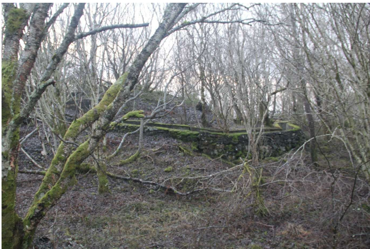
Figur 20. Oppmura løpegrav, delvis i betong og naturstein, sett mot sørvest.
