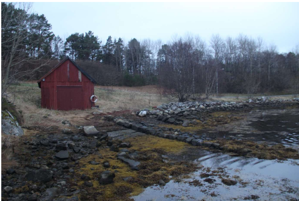
Figur 35. Naust, SEFRAK id nr.1504-0048-034. Gravminna ligg på ein rygg i terrenget, til høgre i biletet. Sett mot nordaust.
