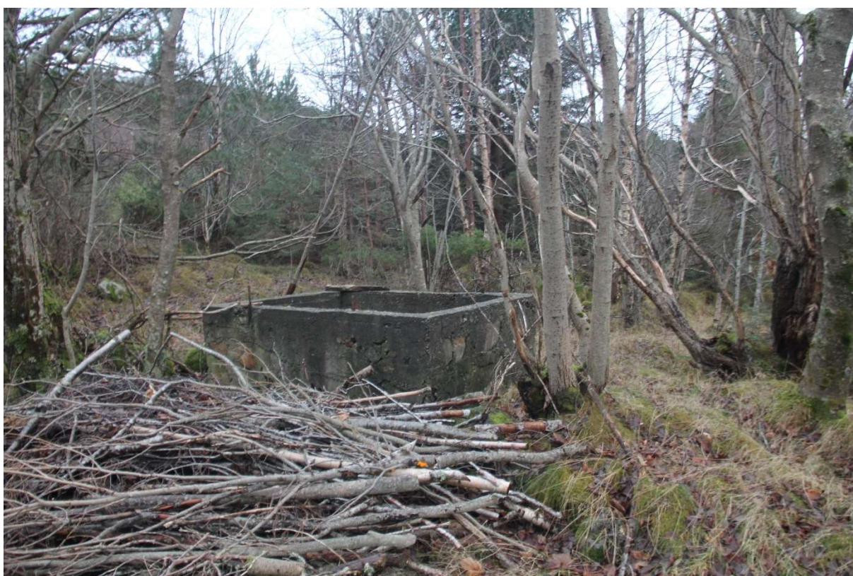
Figur 30. Betongkar, ukjent alder og funksjon.
