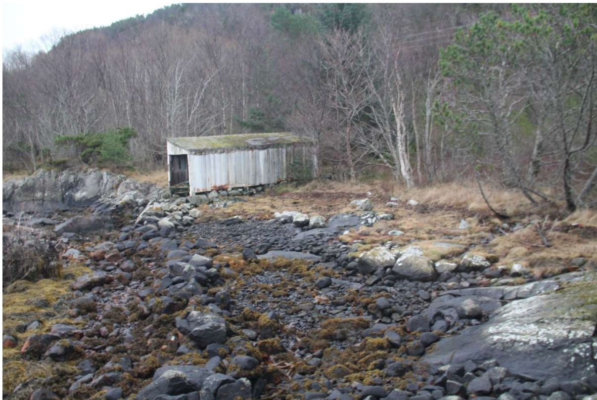
Figur 29. S 3, naust inst i vika mellom fritidseigedomane S 2 og S 3. Sett mot aust.
