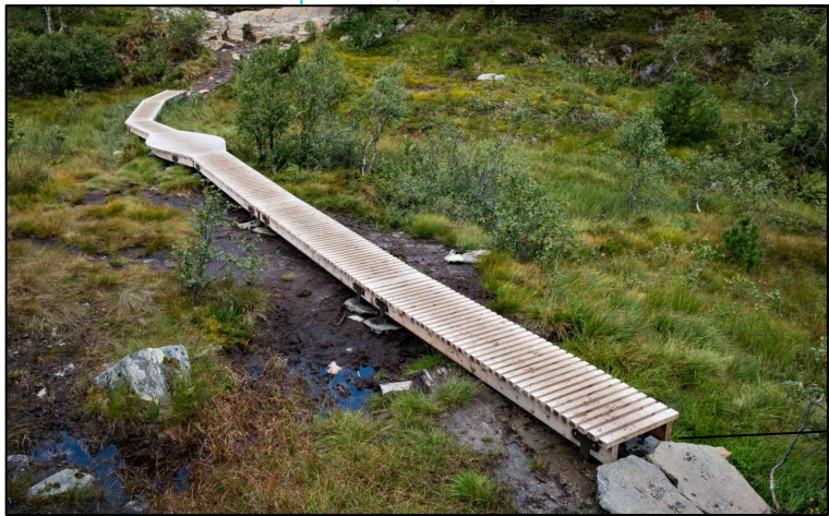
Klopper - gangbane over våt terreng
