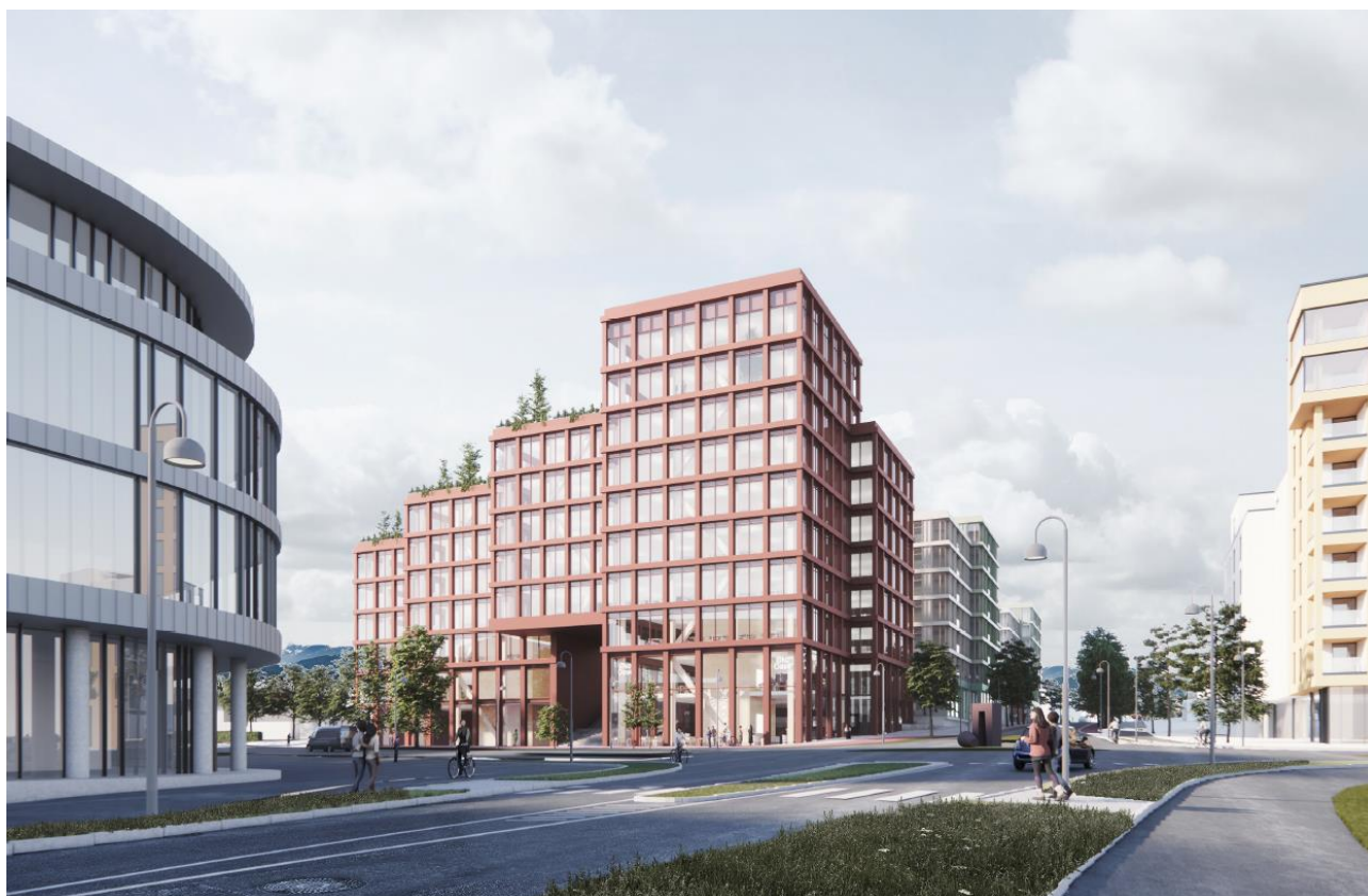
Figur6-2. Tiltaket sett fra øst mot den offentlige delen av løsningsforslaget. Trapp skaper nye forbindelser, og utadrettede 1. etasje langs Borgundvegen og Langelandsvegen gir en urban kant.
