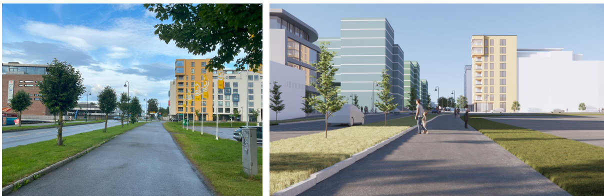
Figur6-9 Tiltaket sett fra Moaalléen. Foto/ill: Norconsult/ JAJA architects.
