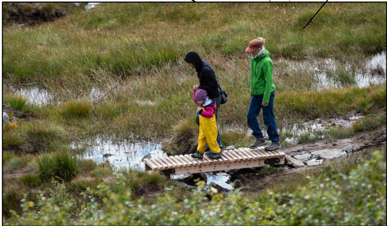
Klopper - gangbane over våt terreng
