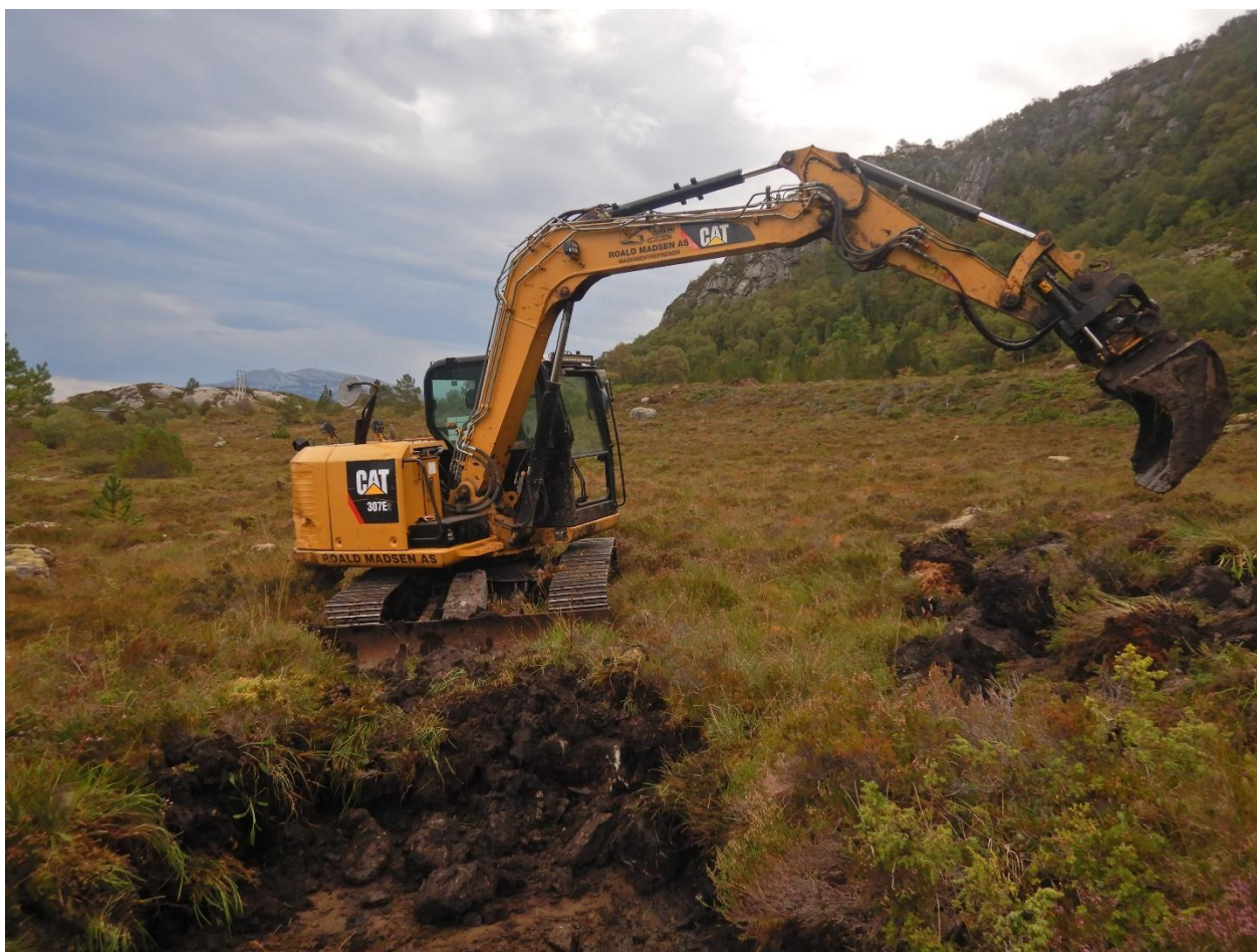
Figur 23 Gravemaskin i full gang med sjakting
