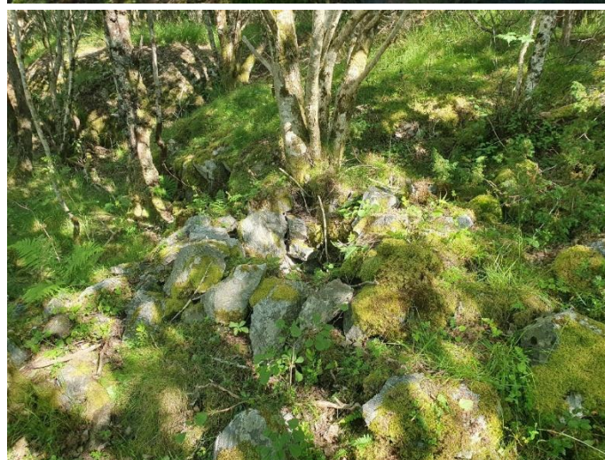
Figur 15 Sammenrast del av bunkeranlegget, noe som viser at området er i ferd med å erodere
