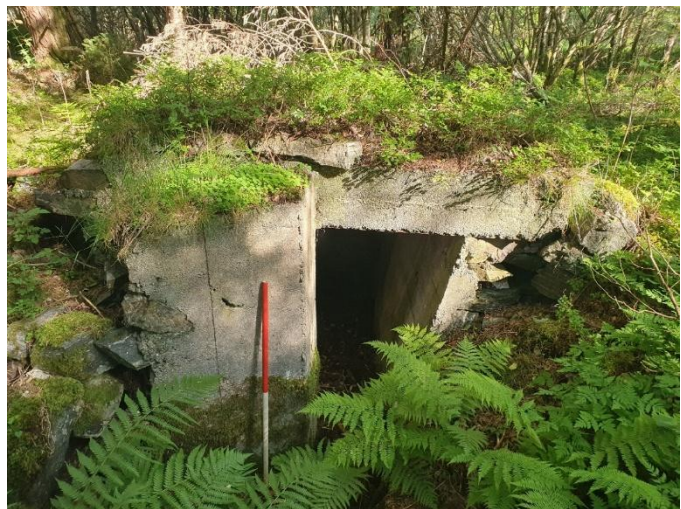
Figur 13 Inngang til liten bunker
