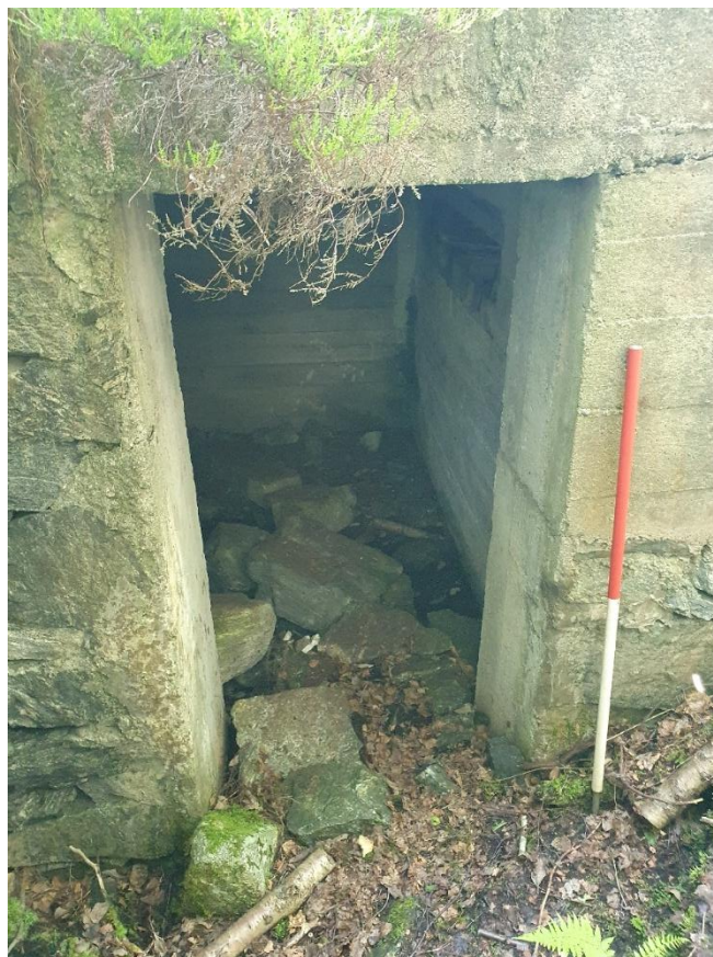
Figur 11 Inngang til liten bunker
