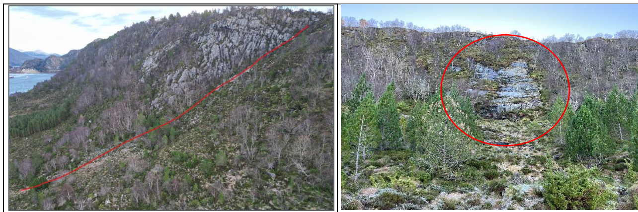
Figur 17: Venstre: ingen tydelig skredrenne, men har betydning for faresone. Høyre: Torv har løsnet fra berget og glidd ned.
